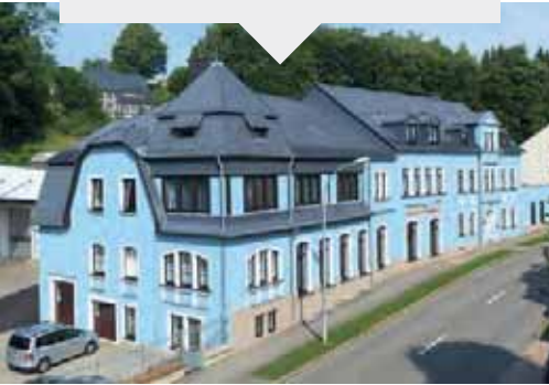
Standort Geyer (Erzgebirge) Site Geyer BÜSCH Armaturen Geyer GmbH
