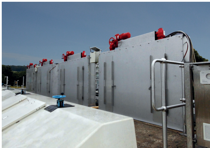
Opláštění pro ochranu šoupátek vyčnívajících ze stavebního objektu
