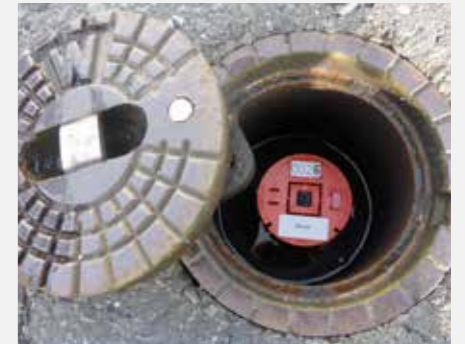
Příklad montáže kotouče IF-Fix na domovní přípojku
