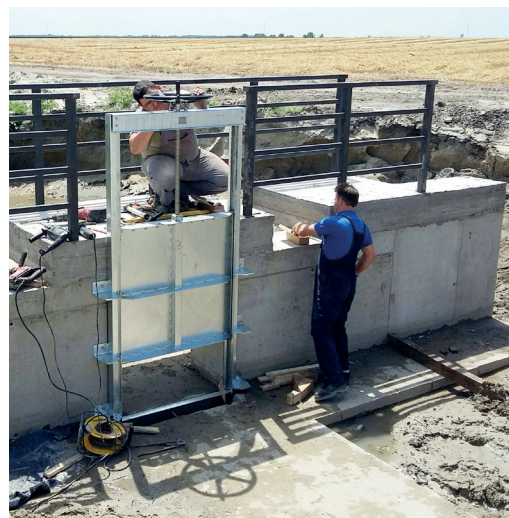
Závlahové zařízení v Chorvatsku, šoupátko 1000 x 1000 mm
