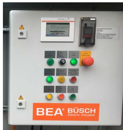
Řídicí jednotka BÜSCH s odvodem čisté vody, WW Naunhof
