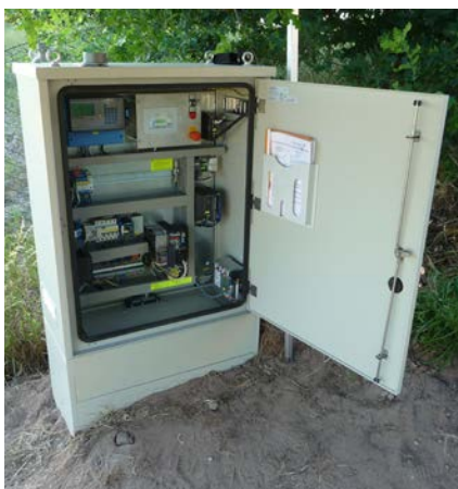
Řídicí jednotka pro armatury od firmy BÜSCH se vzdálenou údržbou nouzovým napájením
