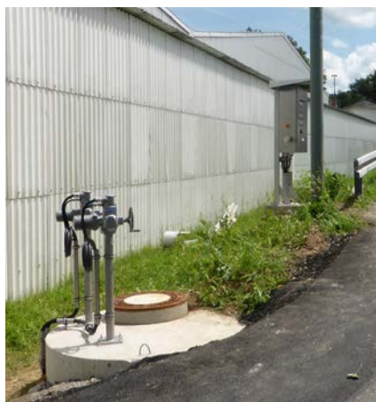
Řídicí jednotka BÜSCH se zadržováním vody na hašení
