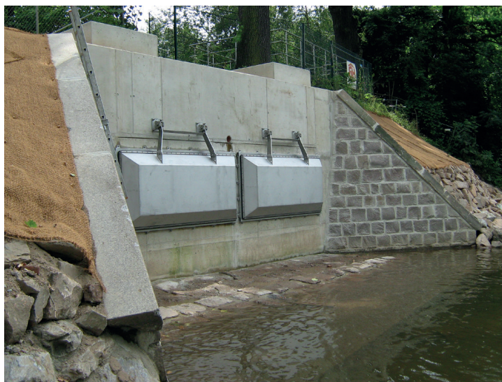
Zwei Entlastungsklappen, jeweils 2600 × 1100 mm
