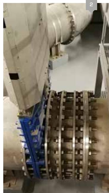
3 PA-Stück aus epoxidbeschichtetem Stahl, BFM, DN 200 mm
