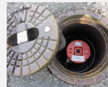
ID-Fix zainstalowany na przyłączy domowym
