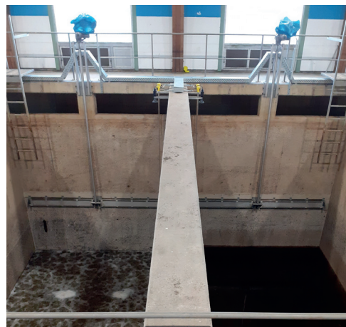
Dvojitý otočný přepad s ovládáním z přední strany s elektrickým pohonem. Čistírna odpadních vod, Německo
