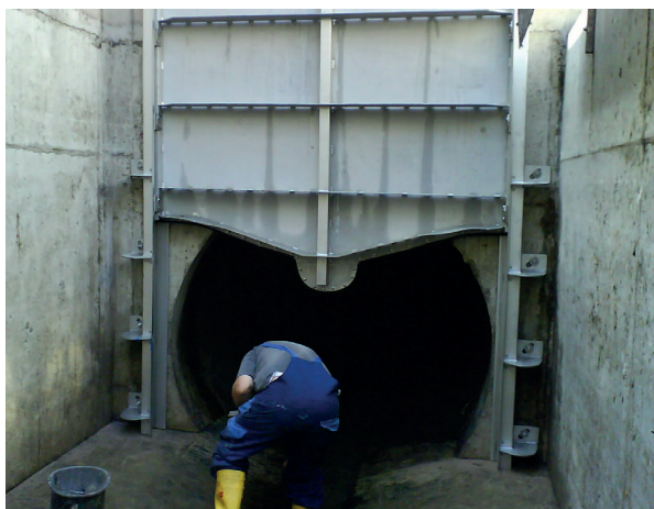
Zasuwa wrzecionowa z płytą dostosowaną do dna kanału
