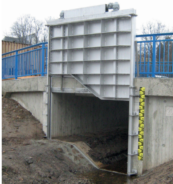
Zasuwa z ukształtowanym dnem dla kanałów o specjalnym przekroju
