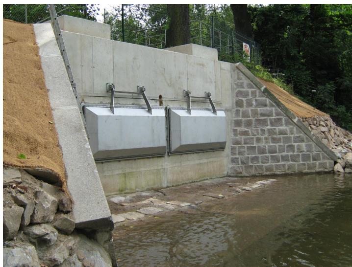
Dvě výkyvné klapky, každá o rozměru 2600 x 1100 mm
