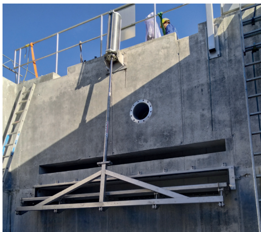
Wrota uchylne ze sterowaniem od przodu za pośrednictwem napędu pneumatycznego, Szwajcaria
