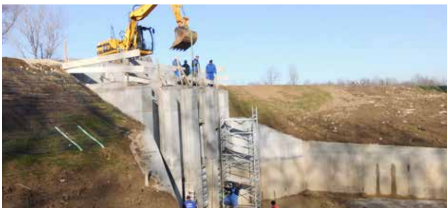
Montage der vier XL4 Absperrschieber in das Bauwerk
