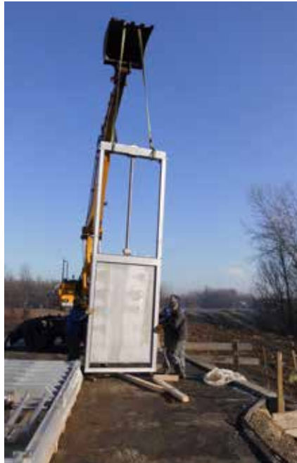
Vorbereitung der Installation
